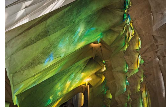
Voltes de la cantoria, construïdes amb prefabricats de formigó i amb formigó fet in situ .
