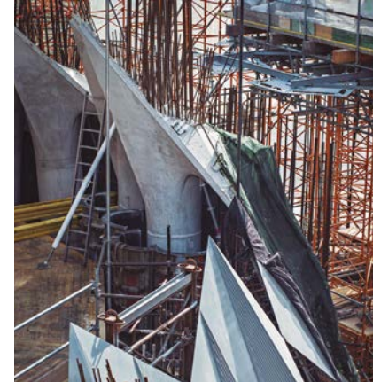
Columnes i capitells de formigó blanc de la Sala Creuer. Les columnes s'han formigonat in situ amb motlles de polièster, i els capitells s'han prefabricat amb motlles de polièster en el temple i s'han elevat fins al lloc corresponent amb la grua.
