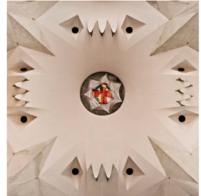
Voltes de la nau lateral, construïdes amb formigó blanc vist i amb encofrats de polièster i fibra de vidre.
