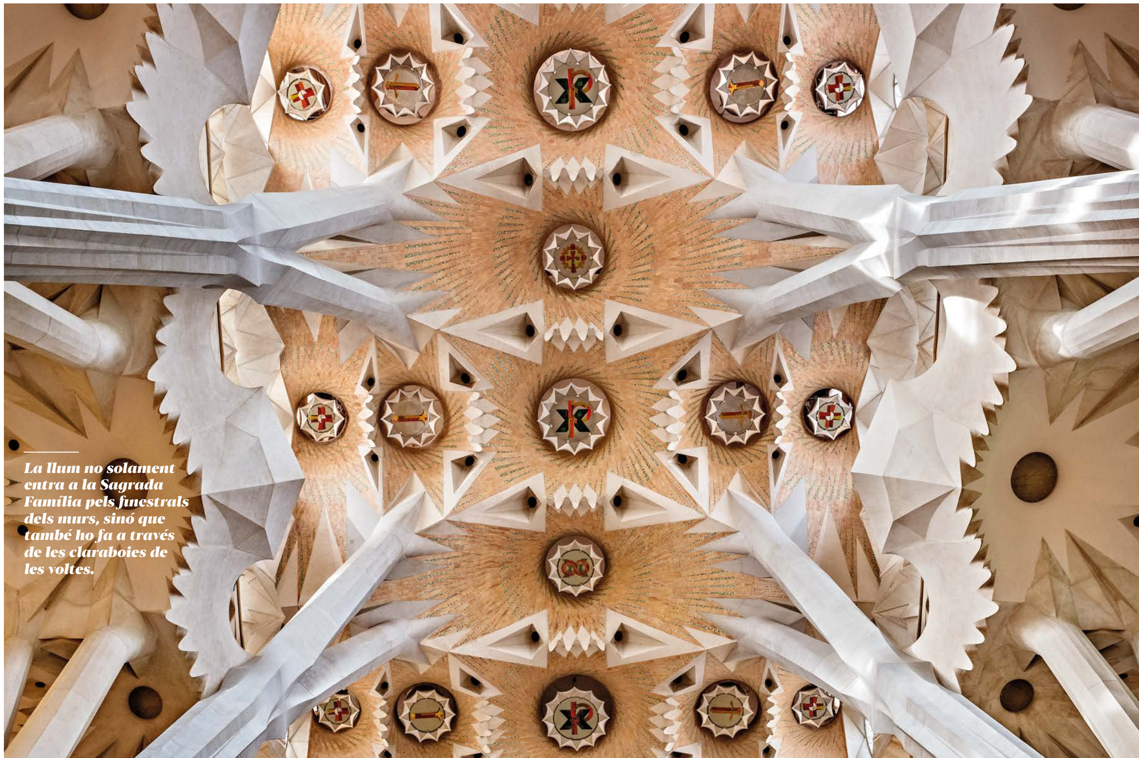
Lluernes o claraboies de les voltes de la Basílica en forma d'hiperboloides.
